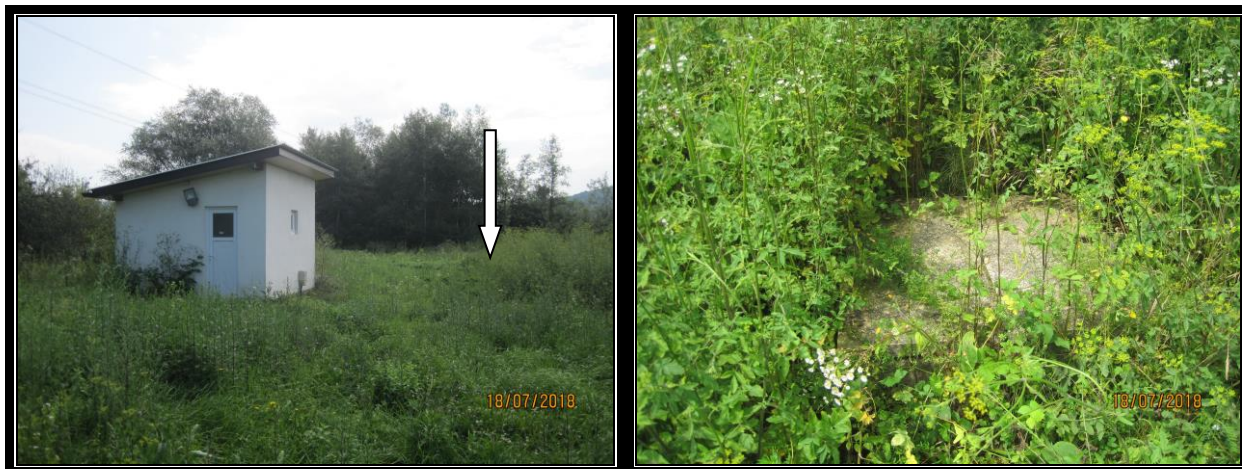
Slika 8: Lokacija i betonski šaht dubokog bunara izvorišta „Trebišnjica“
